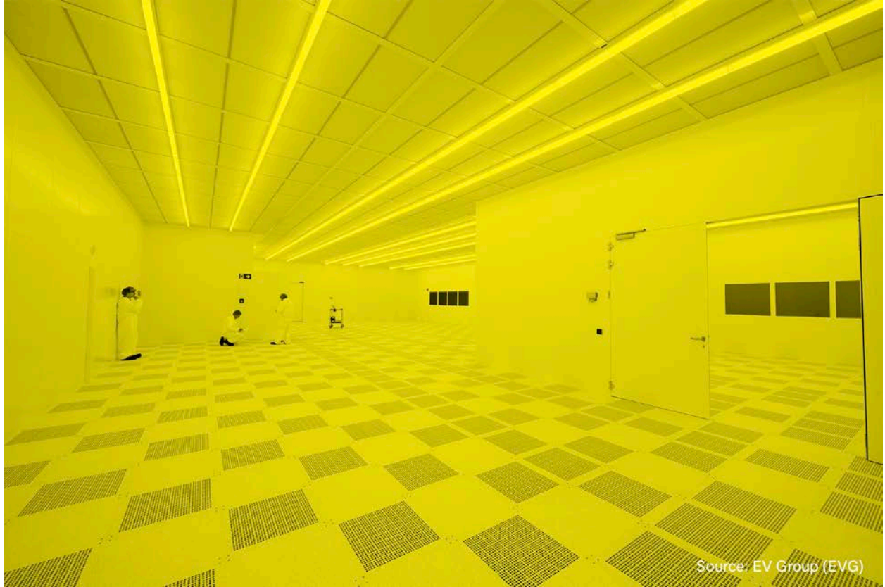
Cleanroom V 大楼内部，工作人员正在调试设备
